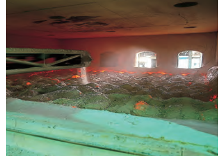
直接通電式ガラス溶融炉の内部
